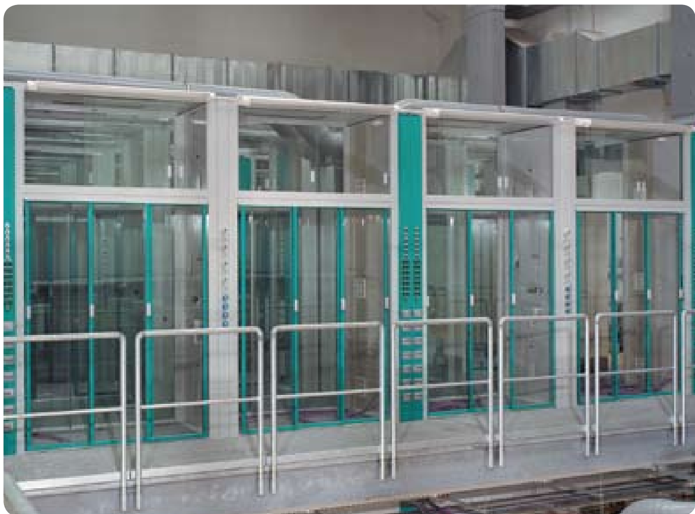
Intégration très précise à la structure du bâtiment
